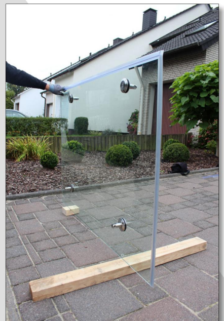
10 Einschrauben des Glas-Stange-Halters
