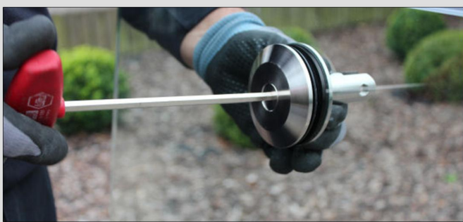
10 Einschrauben des Glas-Stange-Halters
