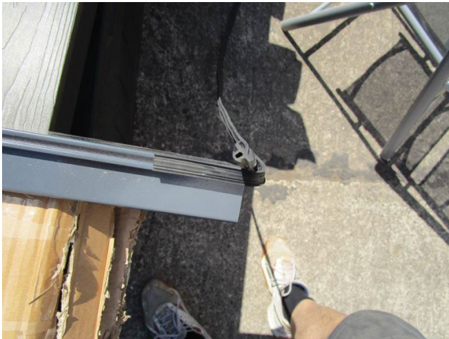
Schritt 7.2b - Abdeckblech mit der Führung oben einführen
