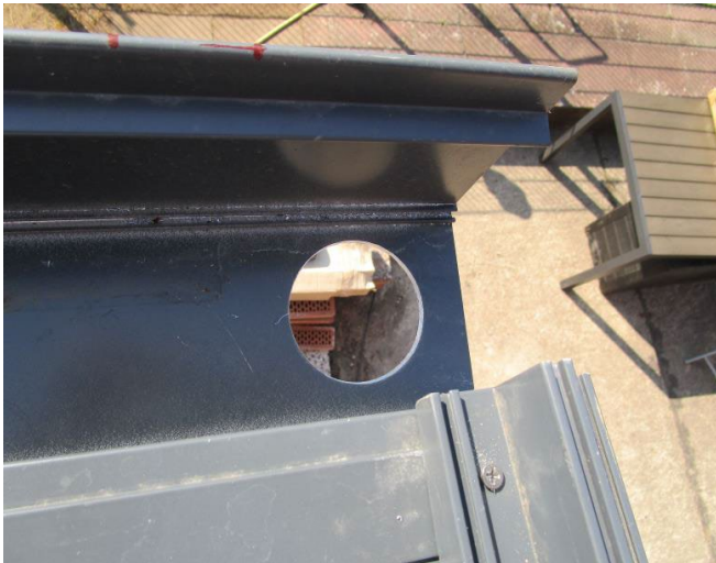
Schritt 8.2b - Pfosten Rechts Bohrung für Abfluss ganz nach innen
