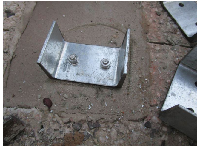
Schritt 13.2e - Fertig Dübel festgezogen
