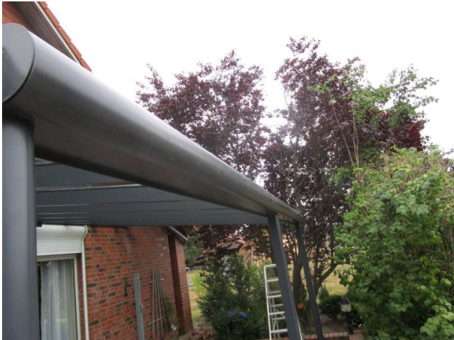
Schritt 30. - Frontabdeckung aufgesetzt mit Holzklötz und Hammer von oben leicht nachhelfen bis sie abschließt
