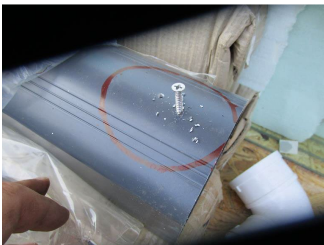
Schritt 4.2a - Im ersten Blech vorbohren mit einer selbstschneidenden Schraube
