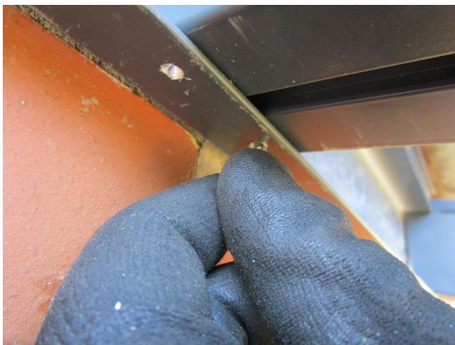
Schritt 4.2e - Querträger mit zwei selbst schneidenden Schrauben befestigen, erst Blech verbohren
