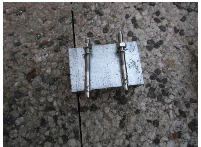
Schritt 13.2a - Metalldübel für die Befestigung
