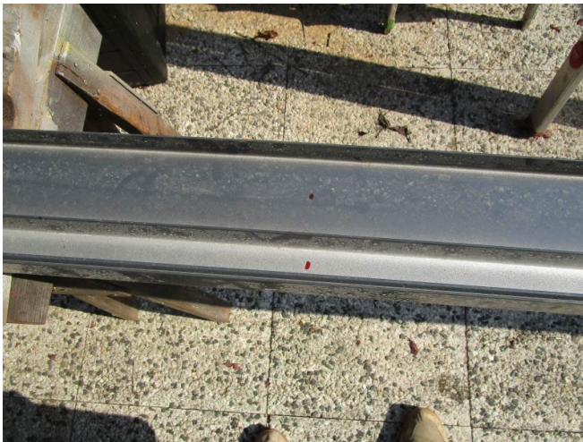
Schritt 2.1 - Alle 50cm zwei weitere Bohrlöcher in der gleichen Höhe anzeichnen
