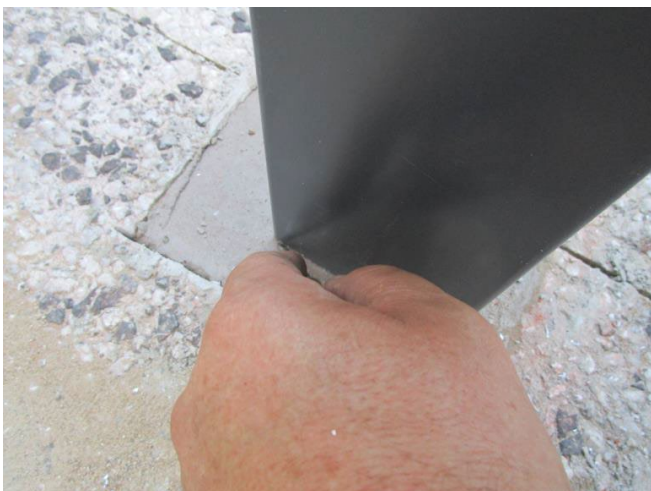
Schritt 13.1. - Pfosten aufgesetzt und anzeichnen für Befestigung
