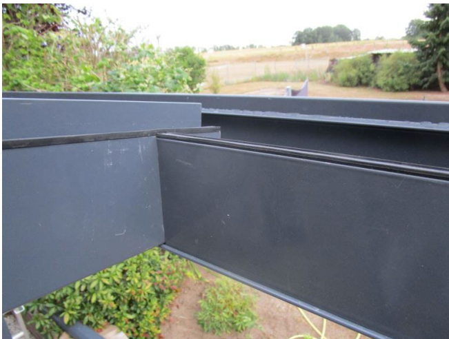
Schritt 23.1 - Abdeckleiste an der Regenrinne aufsetzen, unten ist eine Führungsrinne und oben wird Sie nur aufgelegt
