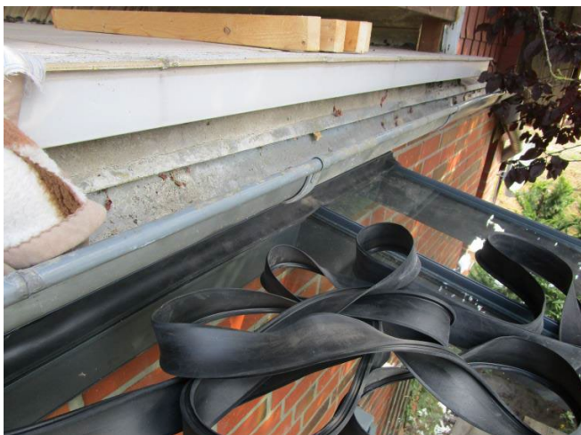
Schritt 26. - Äußere Scheibe eingelegt und Abschlussgummi in die Führung gleich mit eindrücken
