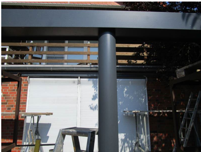
Schritt 15.1. - Mittig setzen und oben befestigen
