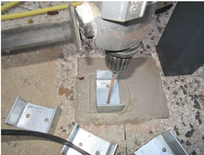
Schritt 13.2c - Befestigung Bohren
