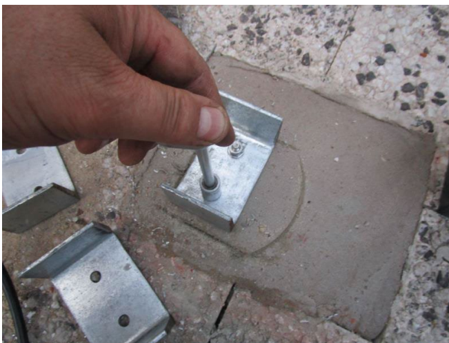
Schritt 13.2d - Dübel festziehen an der Befestigung
