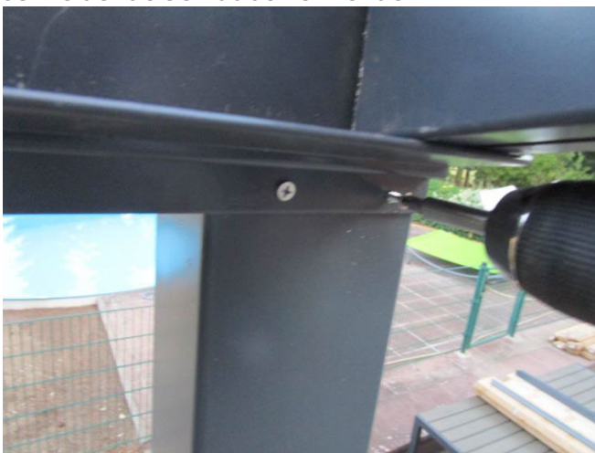
Schritt 10.1a - Pfosten oben Befestigen
