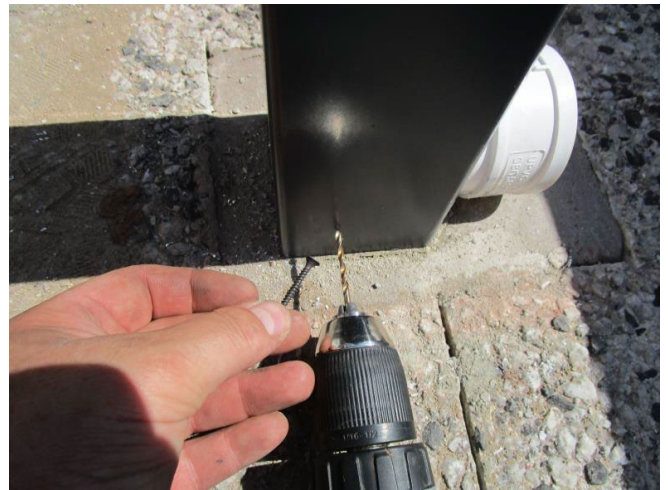
Schritt 16.1a - Rechts unten befestigen, nicht mit Selbstbohrschrauben sondern mit Metallschrauben die anderen drehen durch
