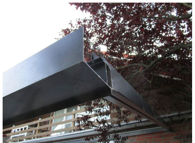
Schritt 4.1a - Den Querträger an der linken Seite ausrichten
