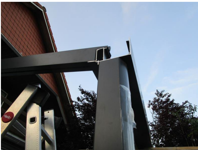
Schritt 9 - Pfosten an der rechten Seite untergestellt passt, wieder Abnehmen für Regenrohr einsetzen
