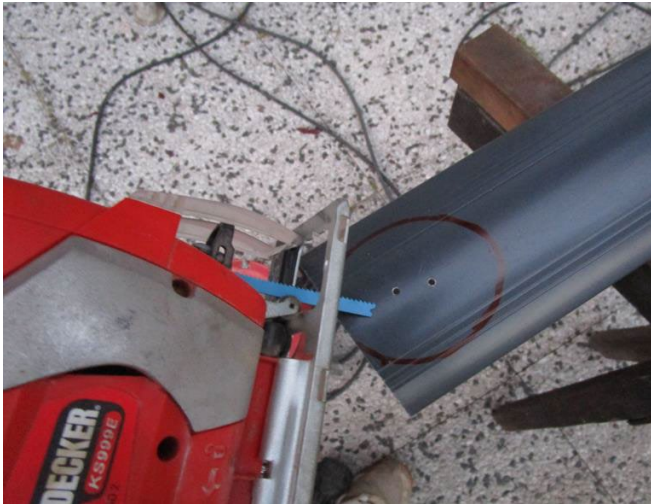
Schritt 8. - Dachrinnenablauf zum aussägen vorbereiten, rechter Pfosten
