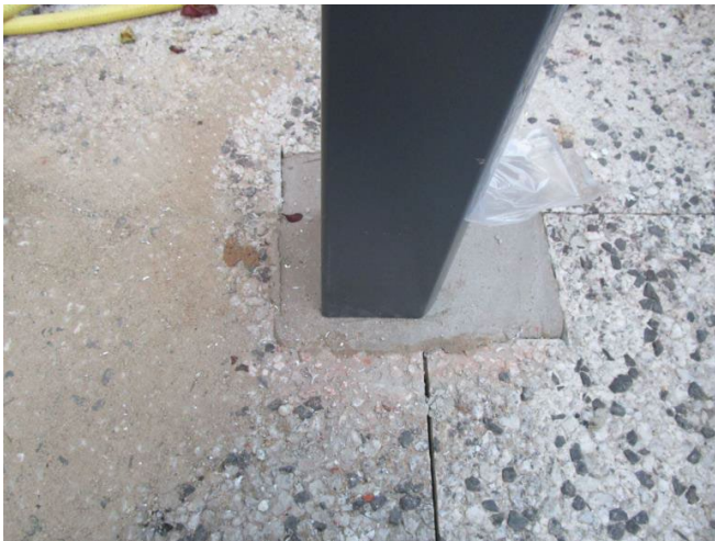
Schritt 13. - Pfosten aufsetzen auf Standpunkt vorher oben angeschraubt und hängend
