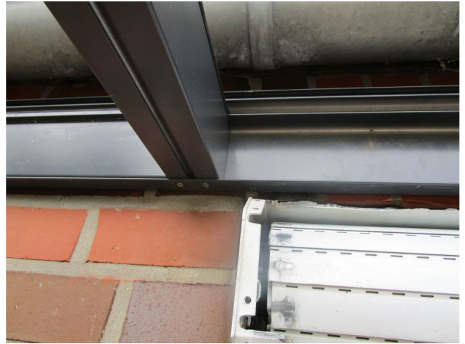
Schritt 22.1. - Abdeckleiste an der Wand hier einsetzen
