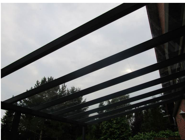
Schritt 31. - Alle Scheiben eingesetzt
