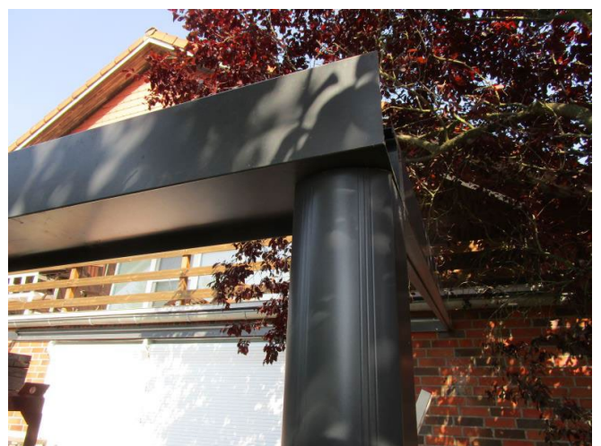
Schritt 14.1 - Links setzen und befestigen
