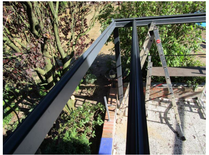
Schritt 18.2 - Zweiten Querträger einführen, angefangen von der links, je nachdem wo die Schmale Seite hin soll
