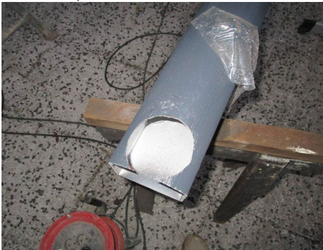
Schritt 8.1 - Pfostenablauf aussägen
