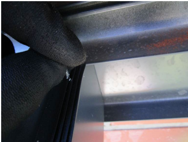
Schritt 4.2 - Befestigen mittels selbstschneidender Schrauben
