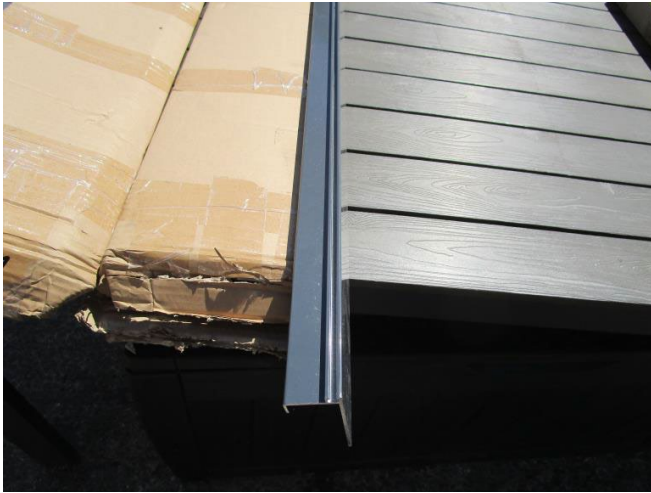
Schritt 7.2a - Abdeckblech mit Führung nach oben kommt an die Regenrinne
