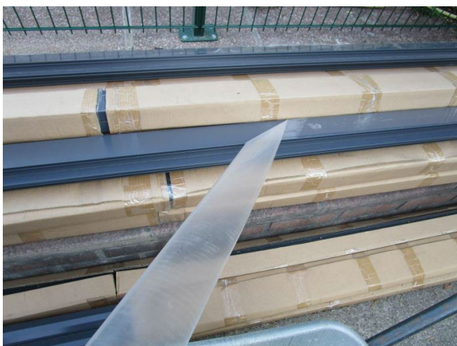
Schritt 6 - Die Schutzfolie abziehen
