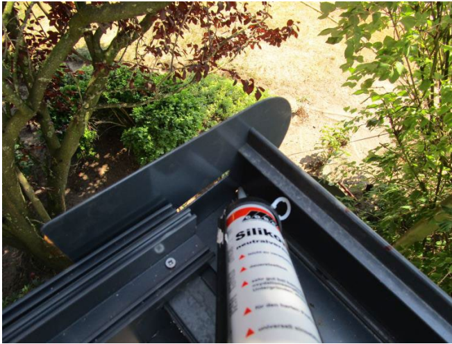
Schritt 18. - Abdeckung der Regenrinne links Innen mittels Silikon abdichten
