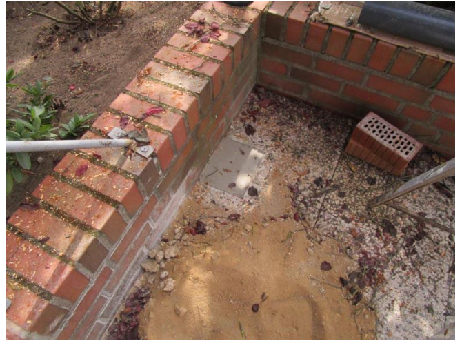
Schritt 11. - Pfosten Befestigung 1. Pfosten fertig, Abstand der Pfosten Explosionszeichnung entnehmen
