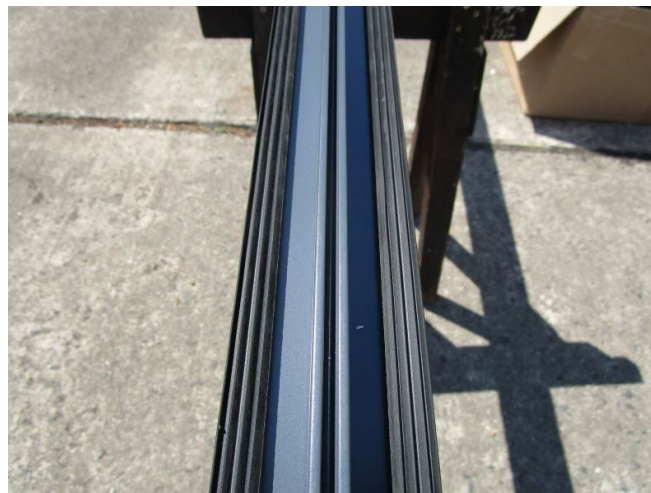
Schritt 7.1 - Eingesetzte Abdichtungsgummis
