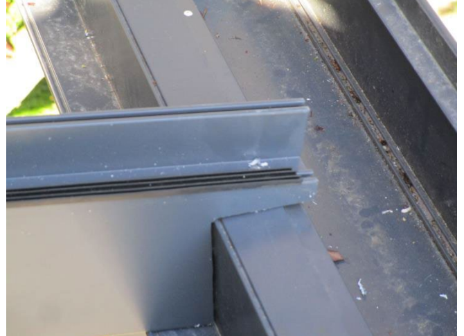
Schritt 19.2a. - Erst das Blech vorbohren dann geht es leichter
