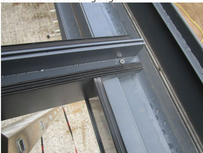
Schritt 23.1a.- Abdeckleiste an der Regenrinne aufgesetzt
