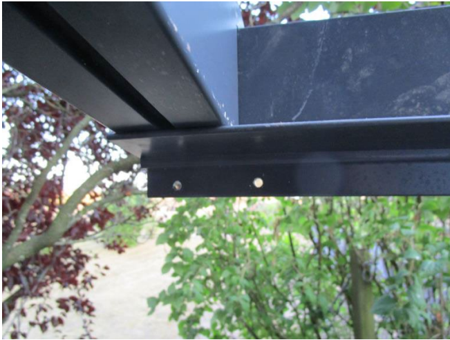
Schritt 12. - Dachrinne linke Seite Vorbohrung für Pfostenbefestigung oben
