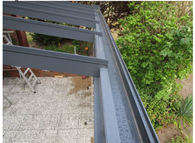
Schritt 23.1c. - Abdeckleisten der Regenrinne eingesetzt
