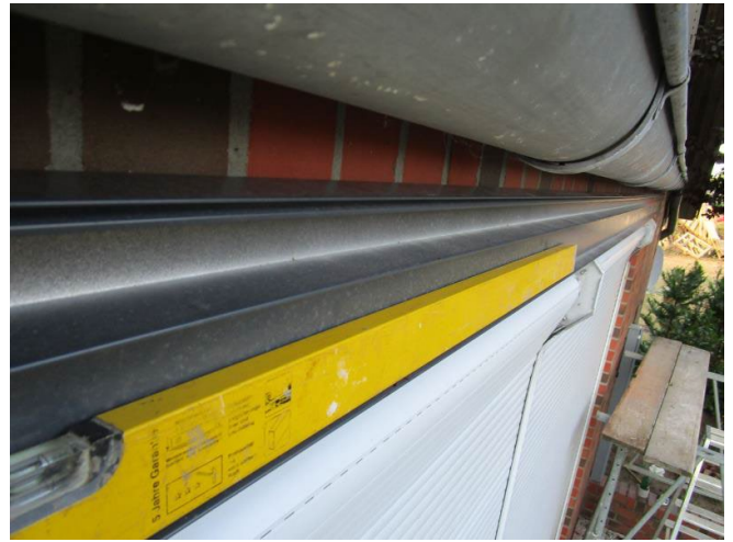
Schritt 2.2a - Und Bohrlöcher setzen und an- schlagen
