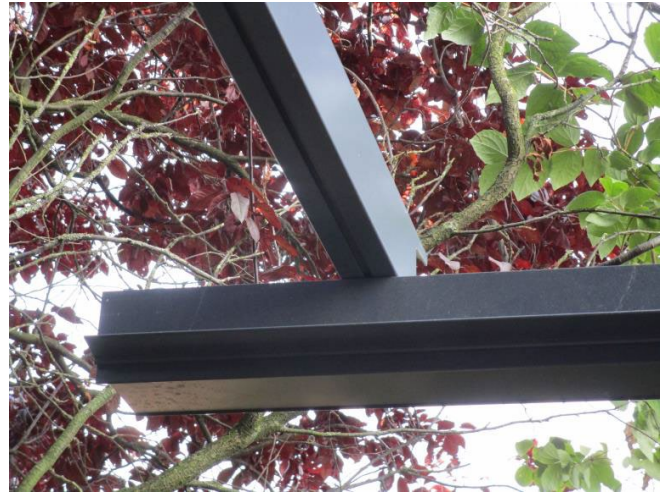
Schritt 4. - Den Querträger auf der Außenseite ausrichten
