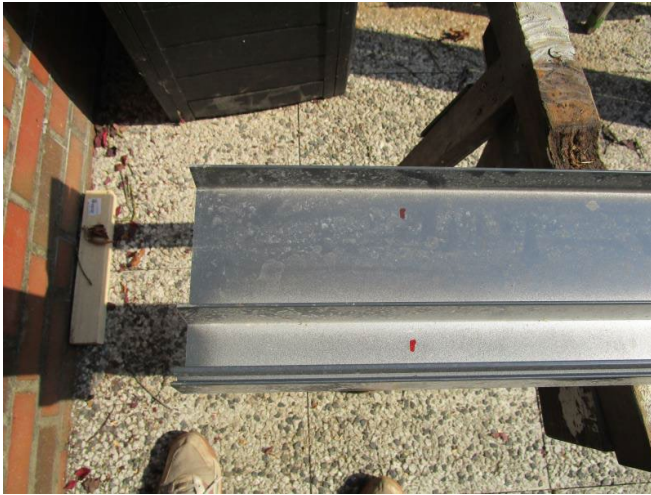
Schritt 2 - Die Bohrlöcher 10 15 cm von der Kante anzeichnen
