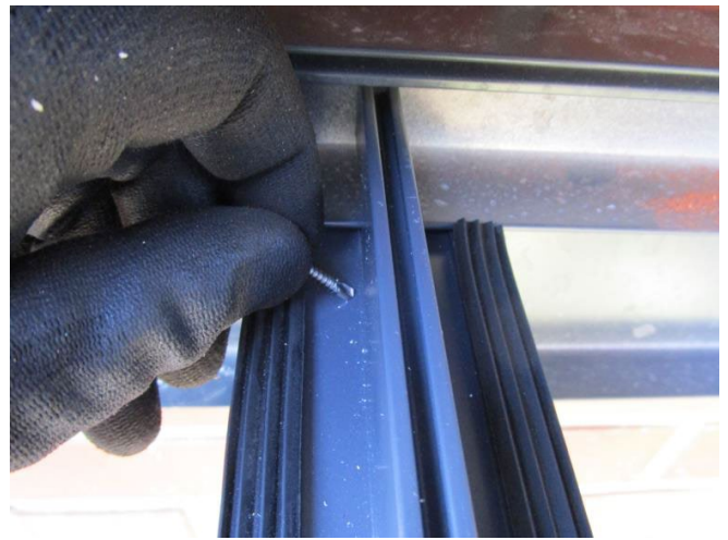
Schritt 4.2b - Den Querträger Befestigen, erst das obere Blech verbohren dann die selbstschneidende Schraube verwenden
