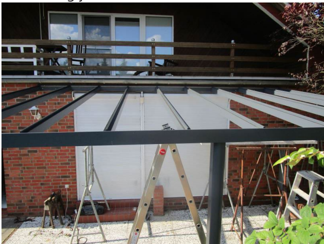
Schritt 21. - Alle Querträger eingesetzt
