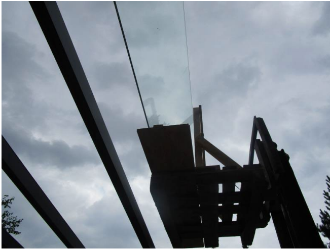
Schritt 29. - Alle weiteren Scheiben einsetzen, wenn keine Technik vorhanden, von der Seite hochkant hoch reichen
