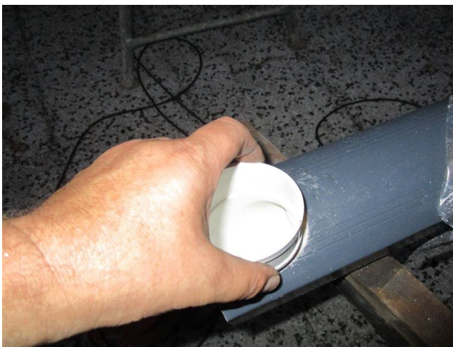
Schritt 8.1a - 90 grad Winkel eingesetzt
