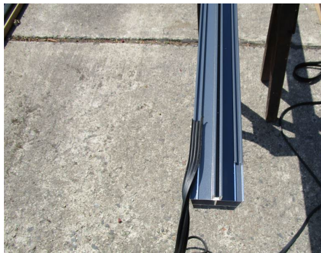
Schritt 7 - Gummi einsetzen
