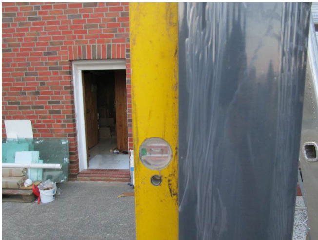
Schritt 15. - Pfosten anbringen und von allen Seiten ausrichten
