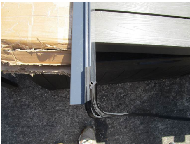
Schritt 7.2c - Abdeckblech einführen
