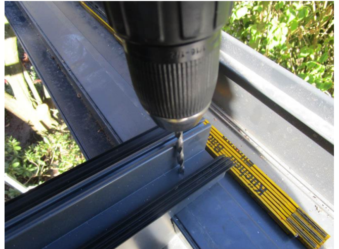
Schritt 19.2. - Querträger an der Dachrinne befestigen
