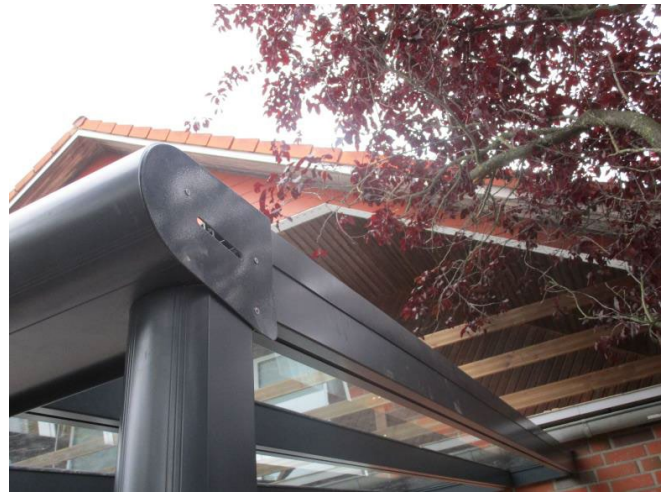
Schritt 34. - Äußere Abdeckung angebracht. Fertig!
