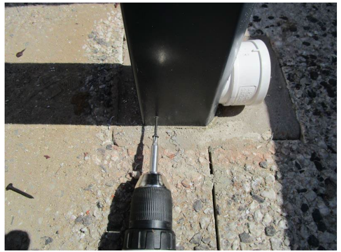
Schritt 16.1 - Pfosten Unten befestigen
