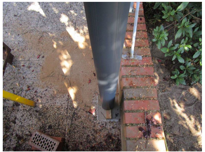
Schritt 14. - Links eingesetzt und oben mit selbstschneidender Schraube befestigt
