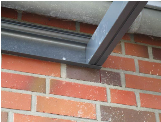
Schritt 4.1b - Sehr wichtig, alle Ecken auswinkeln
