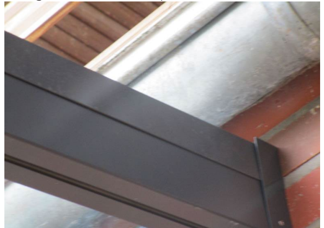
Schritt 33. - Äußere Abdeckleiste aufsetzen und mit drei Schrauben sichern, kein Gummi hier vorhanden, vorbohren leicht anziehen
