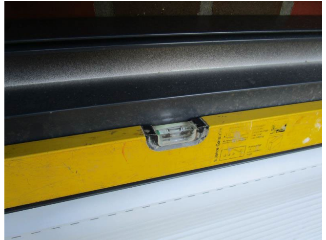
Schritt 2.2 - Mit der Wasserwaage ausrichten
