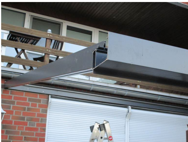
Schritt 5 - Querträger rechte Seite ausrichten
