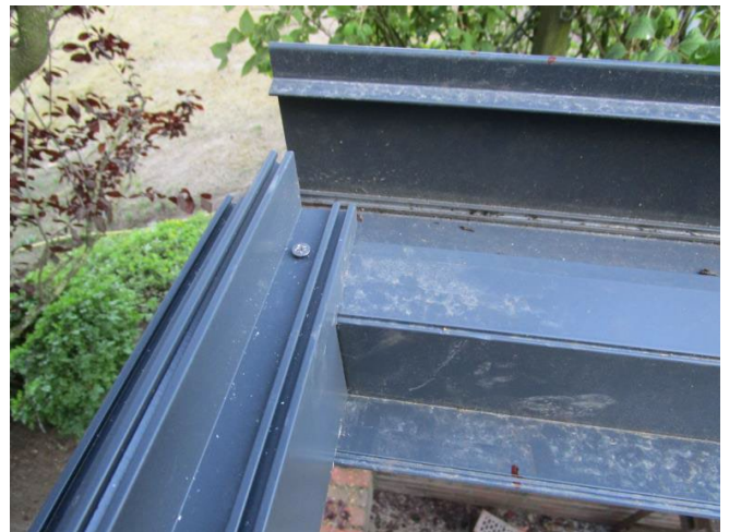
Schritt 4.2c - Der Querträger wurde auf der Seite befestigt
