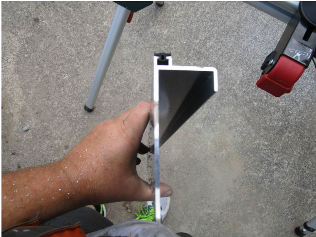
Schritt 23. - Abdeckleiste an der Dachrinnenseite
