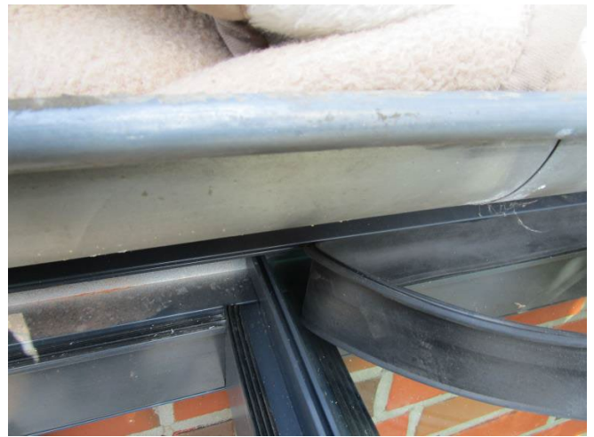
Schritt 26.1 - Abschlussgummi an der Wand eingesetzt immer fortlaufend
