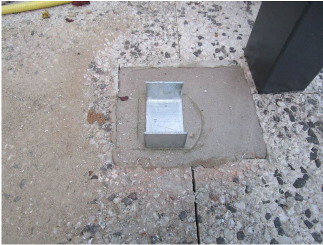
Schritt 13.2b - Befestigung im Winkel aufsetzen
