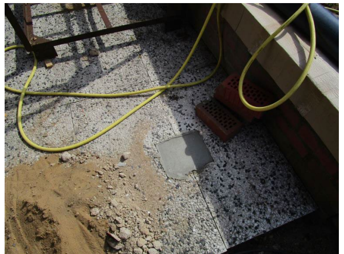
Schritt 11.1a. - Befestigung 3 Pfosten Fertig
