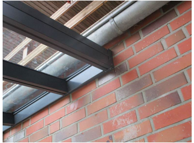
Schritt 32. - Äußer Abdeckung rechts außen an der Wandseite anschrauben und kleine Abdeckung an der Wand (Trapez)
