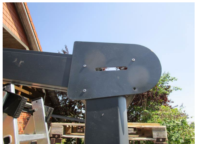
Schritt 17. - Abdeckung Regenrinne verschrauben.
