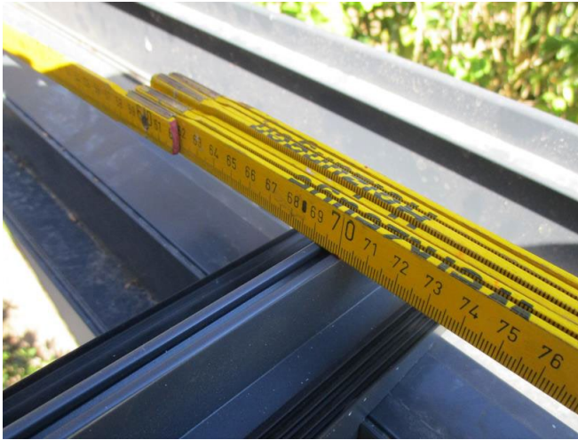
Schritt 20. - Mit einem Abstand von 69 cm einsetzen außer für die Scheibe 38 cm rechts, links oder mittig je nach aussehen
