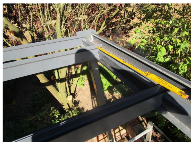
Schritt 19.2b. - Querträger befestigen, hier 39cm Abstand danach 69cm
