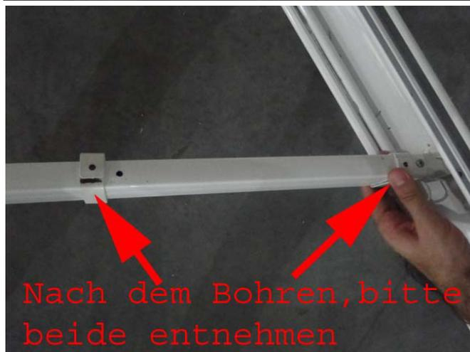
Sie können jetzt die beiden Metallbefestigungen nach dem Bohren entnehmen. Jetzt können Sie den LED Streifen entnehmen:
